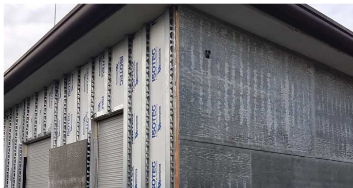
ISOTEC + gipszrost lap, vakolat
