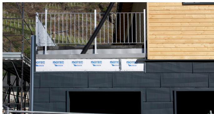
ISOTEC + PREFA alumínium homlokzati burkolat
